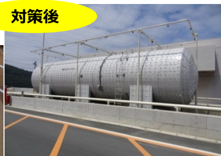
竜巻防護対策設備 (例：重油タンクの防護 (緩衝材))
