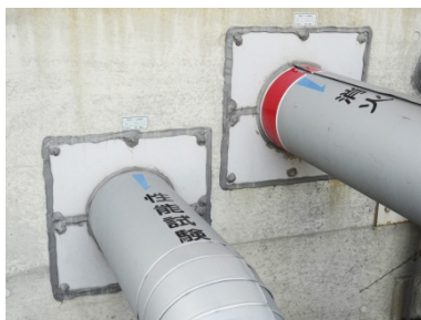
防水シール施工
