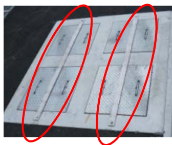
飛来物発生防止対策 (例：チェッカープレートの固定)
