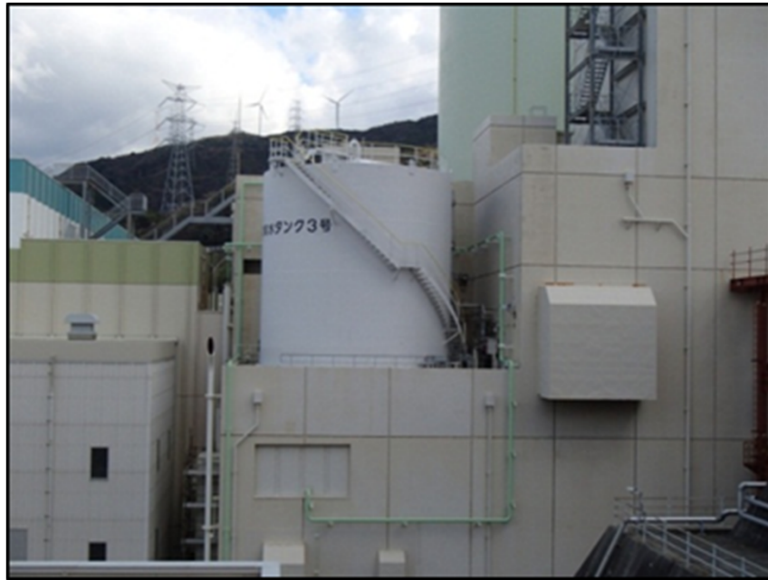
【防護対策実施前】
