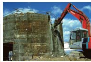
原子炉格納容器の解体
