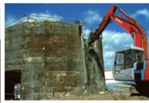
原子炉格納容器の解体
