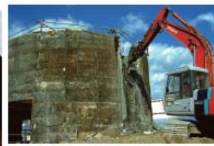
原子炉格納容器の解体
