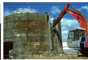
原子炉格納容器の解体
