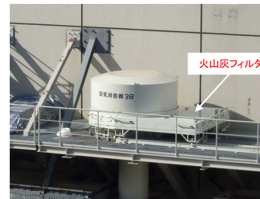
設置後(火山灰フィルタをセットした状態)
