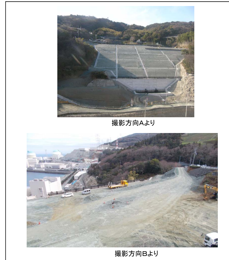
作業スペース①の進捗状況
