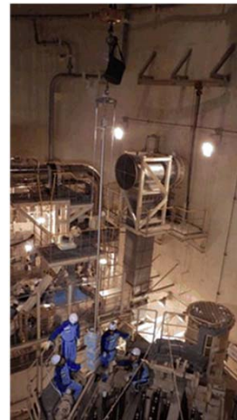
新上部ふたへの機器取付（12月11日撮影）
