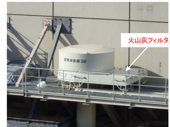
設置後(火山灰フィルタをセットした状態)
