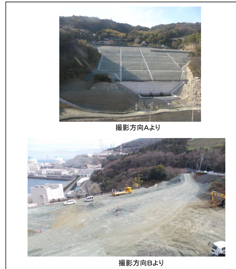
作業スペース①の進捗状況
