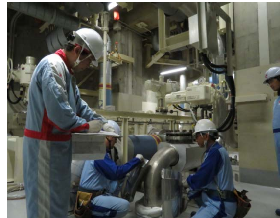
写真1 余熱除去系統配管の汚染の除去実施状況
