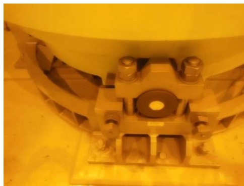
乾式キャスク底部 (固定金具部分)
