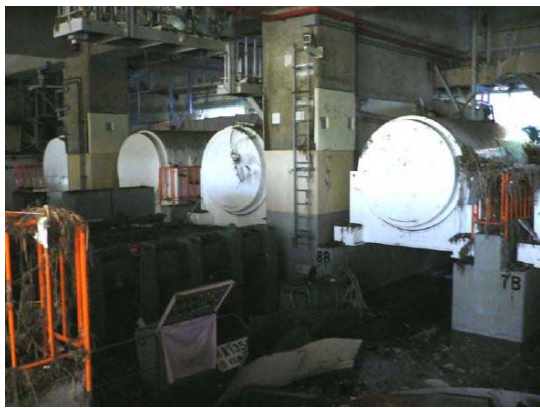
事故後の旧キャスク保管建屋内の状況
