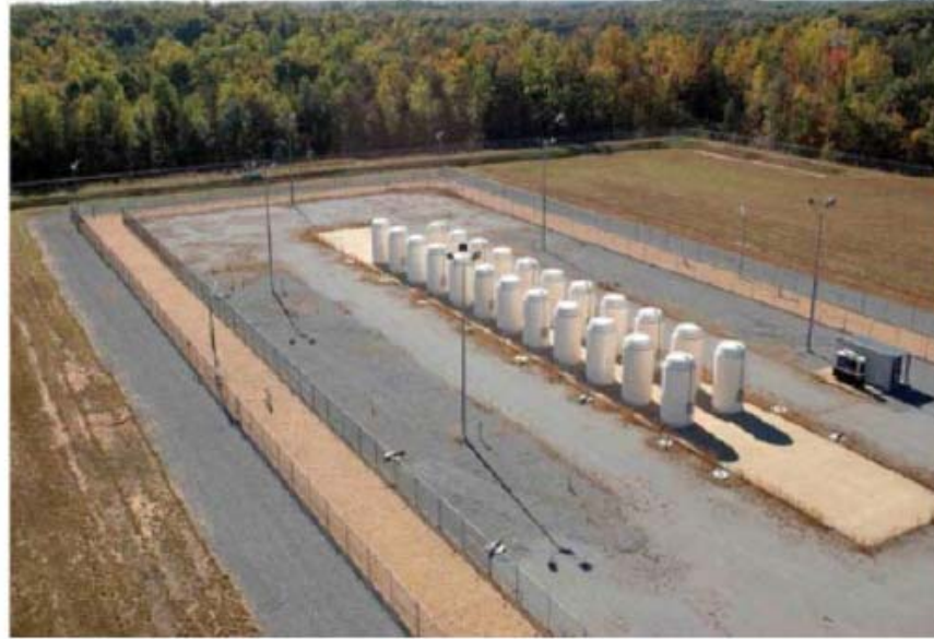
金属キャスク・野外設置方式 米国・ノースアンナ発電所(固縛なし)
