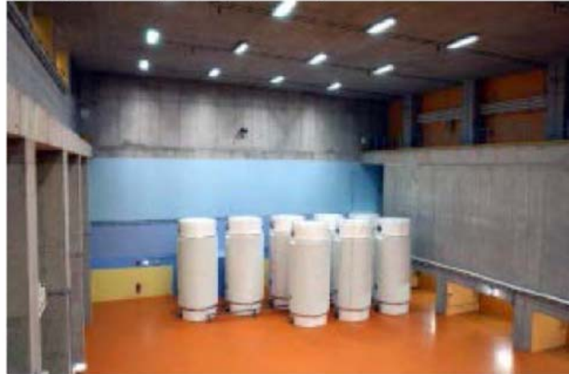
貯蔵建屋有り・固縛なし方式 独国・リンゲン発電所
