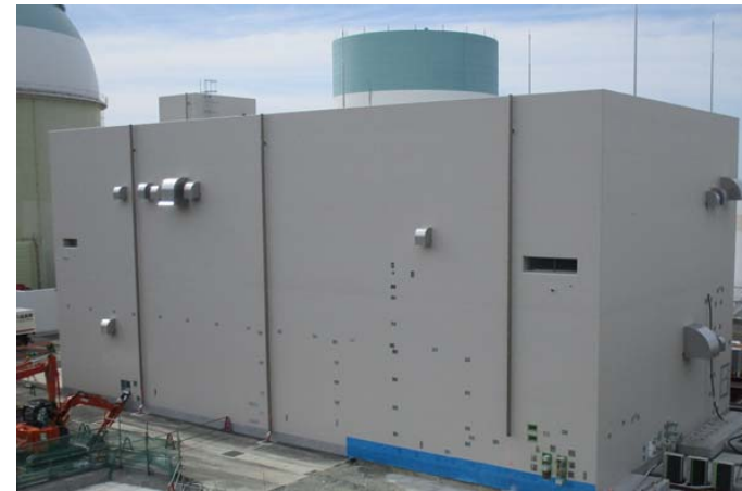
図3 非常用ガスタービン発電機建屋（建設中）
