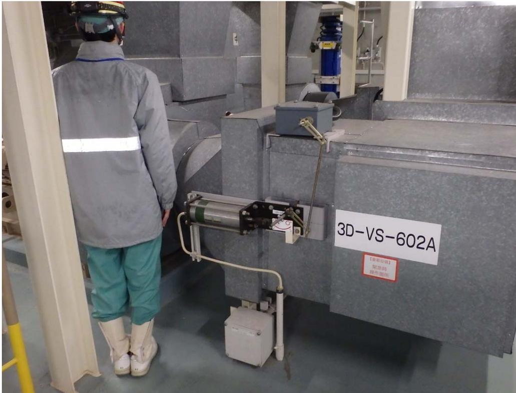
ダンパ外観（空気作動のシリンダにより、ダクト内のダンパを開閉させる）
