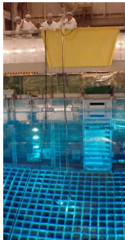
制御棒クラスタ頭部のスパイダ内堆積物除去の概要図
