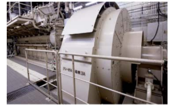
非常用ディーゼル発電機 (DG)
