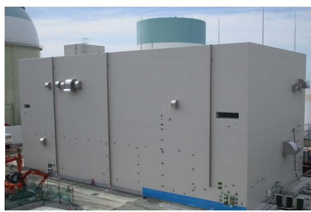
非常用ガスタービン発電機建屋
