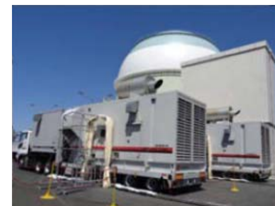
空冷式非常用発電装置 (空冷EG)
