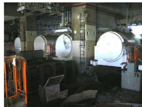
乾式貯蔵キャスク保管建屋の状況（津波が引いた後に撮影）
