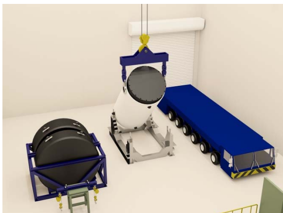
⑩横倒し、専用車両へ積み付け
