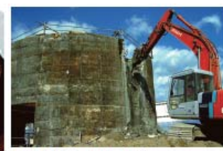
原子炉格納容器の解体
