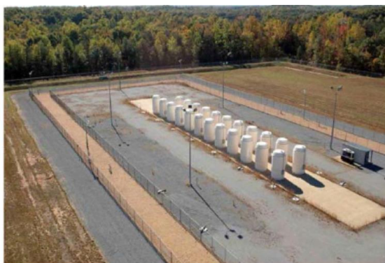
金属キャスク・野外設置方式（固縛なし）
