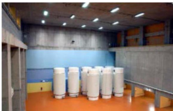
貯蔵建屋有り・固縛なし方式
