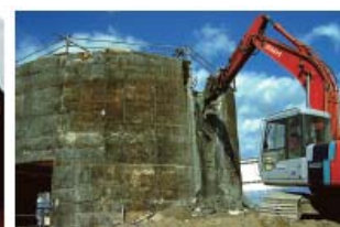
原子炉格納容器の解体
