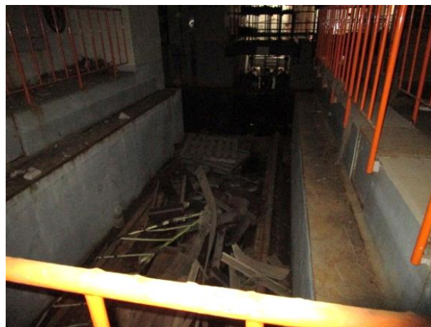
現在の旧キャスク保管建屋内の状況
