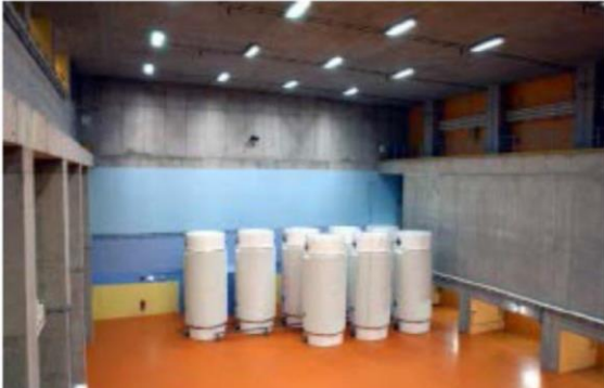
貯蔵建屋有り・固縛なし方式
