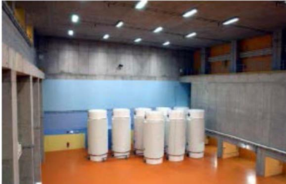
貯蔵建屋有り・固縛なし方式
