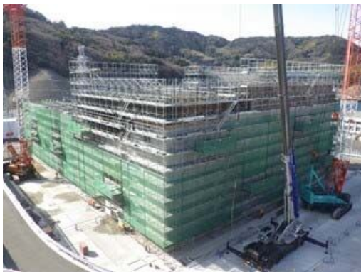
設置工事の状況(令和4年2月)
