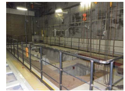
撤去前 撤去後 1号機 非常用ディーゼル発電機の撤去
