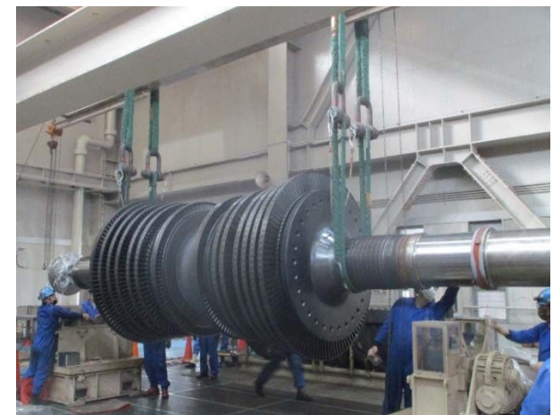
④タービン点検作業
