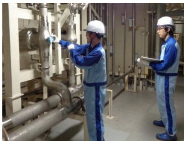
配管外部からの線量当量率測定
