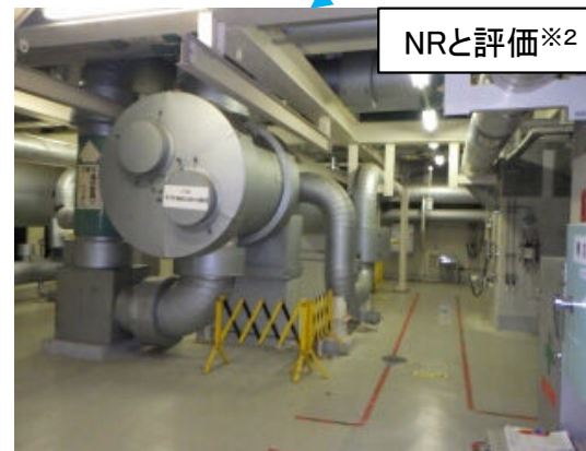
原子炉補機冷却水冷却器
