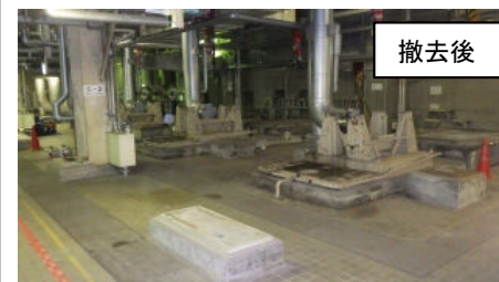
給水ポンプ、付属配管、 監視計器盤撤去
