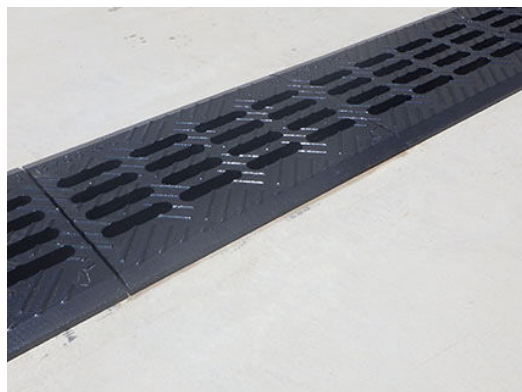
伊方発電所乾式貯蔵施設周辺の 側溝用に設置しているグレーチング
