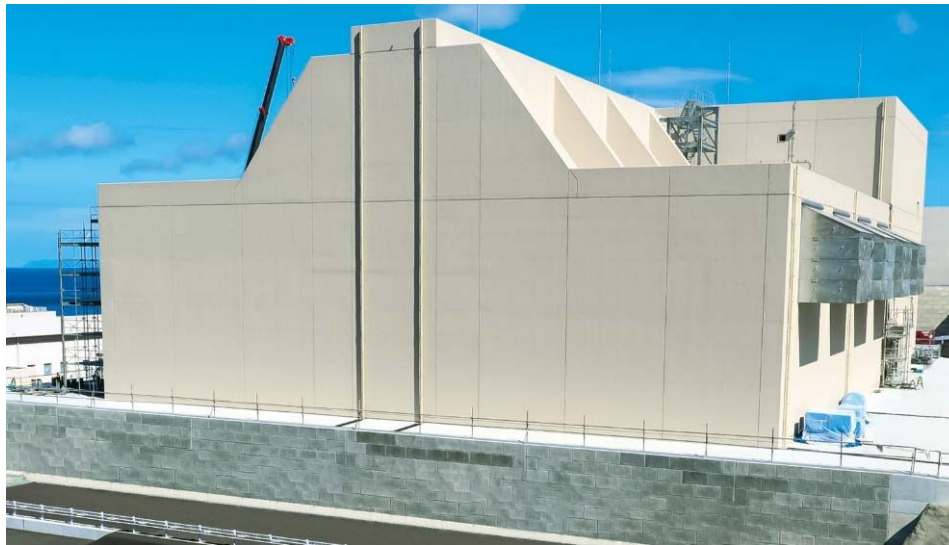
乾式貯蔵施設 建屋外観
