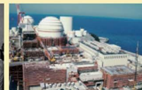
② 3号機建設工事
