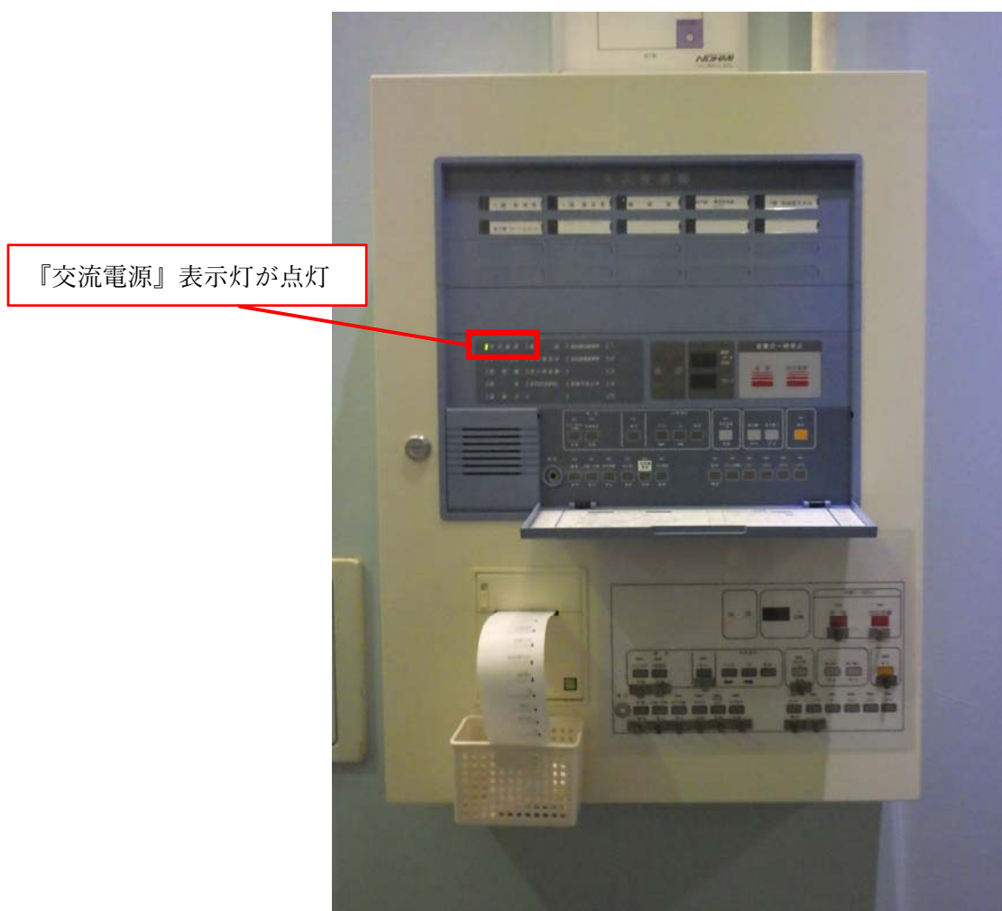
伊方3号機 純水装置建屋内 火災受信機盤 (復旧時)
