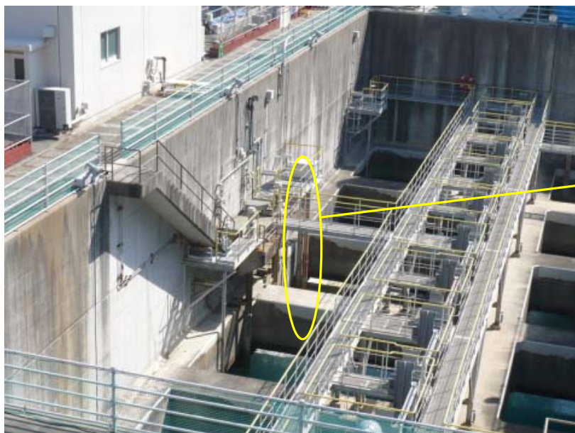
伊方3号機放水ピット水モニタ設置状況
