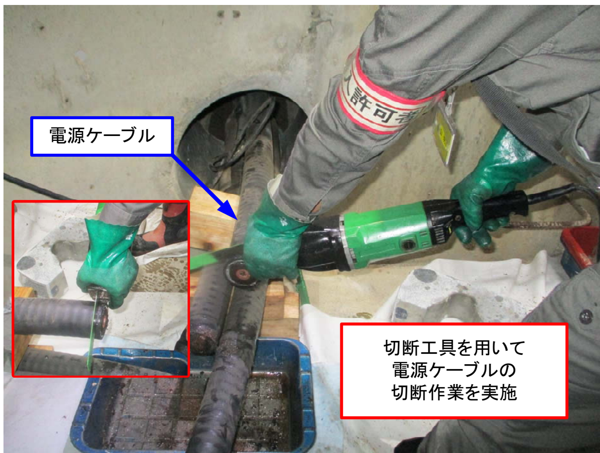
電源ケーブル切断作業時
