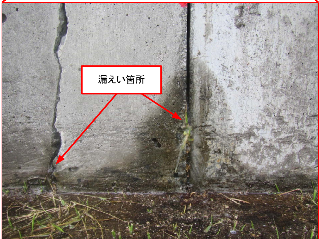
沈殿池 漏えい箇所
