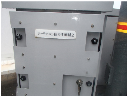
サーモカメラ信号中継盤 2 外観
