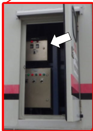
バッテリー充電器盤(矢印箇所)
