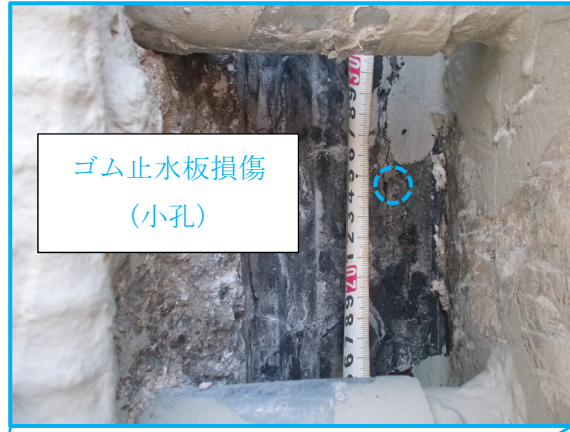
ゴム止水板の損傷
