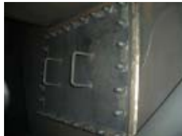
内部マンホール付近点検状況
