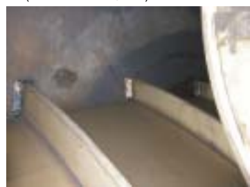
入口衝突板付近点検状況
