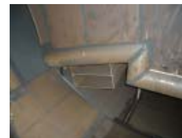
左側蒸気整流板付近点検状況
