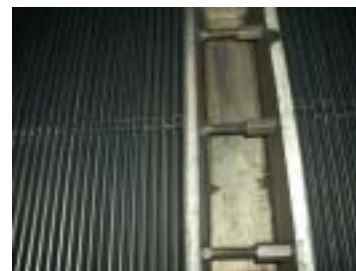
シェロンベンおよびジャッキ ボルト点検状況
